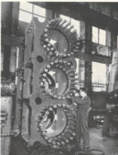
Fordatura ed allineamento ai cilindri di un motore Diesel tipo 205/2 per una motonave da 22000 T.D.W. in costruzione al Cantiere di Livorno per la Compagnia panamense « Las Minas ».
